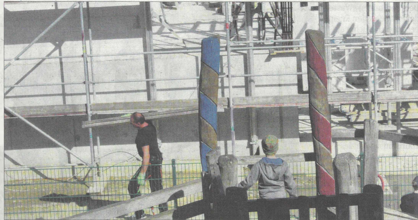
Neugierig schaut ein Kind vom Kindergarten nebenan aus auf die Baustelle der Weferlingen Grundschule. Dort werden der Altbau saniert und der Neubau hochgezogen.
