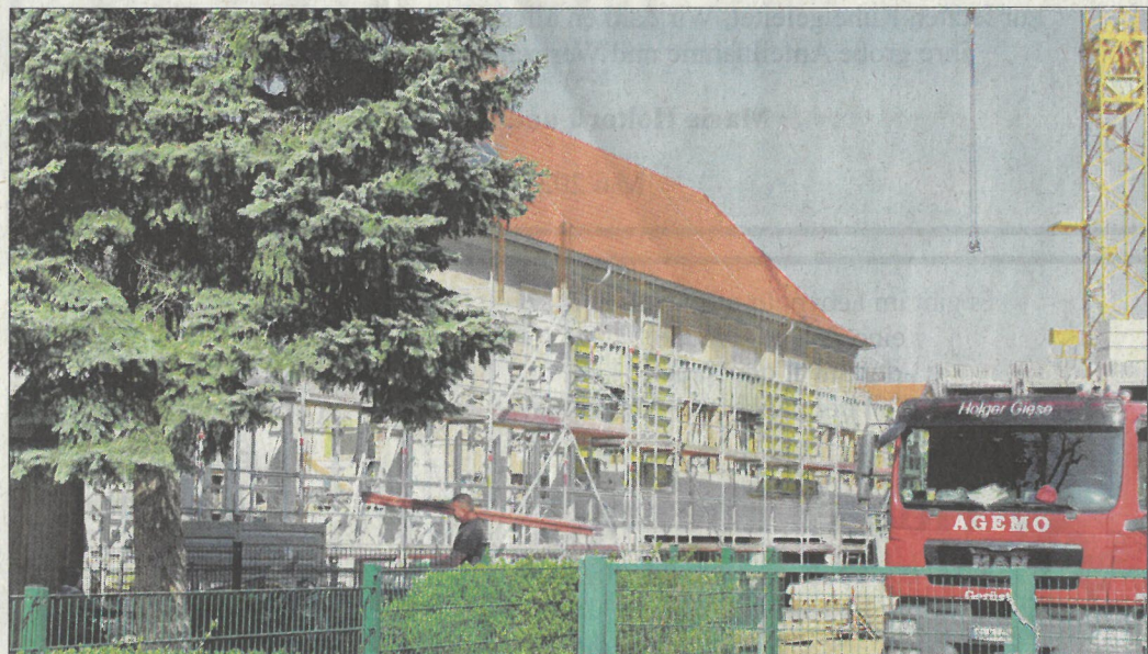
Mit dem Wachsen des Grundschulneubaus in Weferlingen wächst auch die Vorfreude auf die nagelneue Grundschule. In der Verwaltung wird bereits an der Innenausstattung gearbeitet. Foto: Carina Bosse
